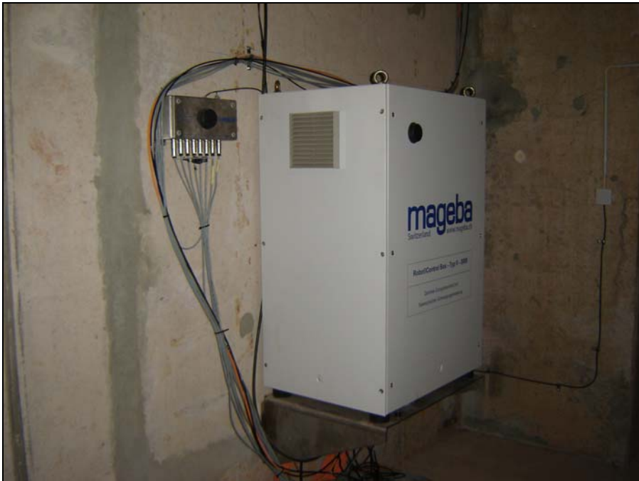
Fig. 4. Die Messdateneinheit, die so genannte Robo®Control Box vom Typ I (klein, silberfarben) für konventionelle Messungen und vom Typ II mit integriertem Laserinterrogator (gross, weiss).
