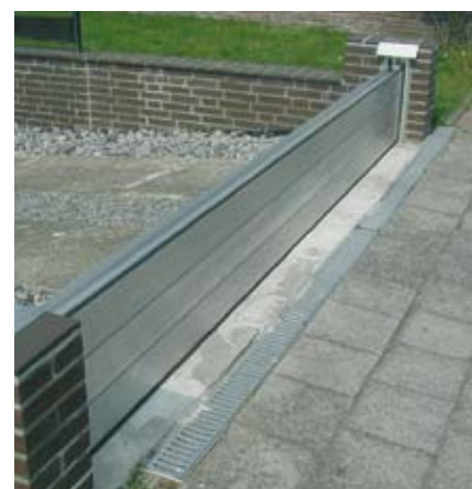
Abbildung 5: Barrierensystem an Grundstücksgrenze
